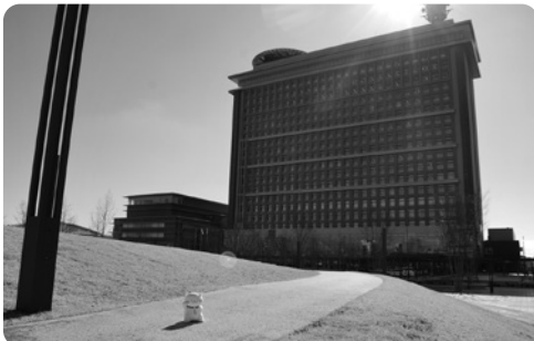
北側正面は公園となっております。芝生と太陽を感じながら散策することも可能です。
